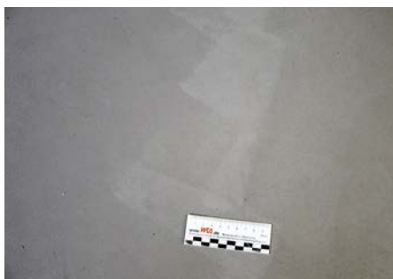
(7) Ein ungleichmäßiger Auftrag der Versiegelung führt zu einem störenden Erscheinungsbild.
