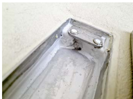
(3) Silikon als improvisierte Abdichtung im Bereich der Duschrinne
