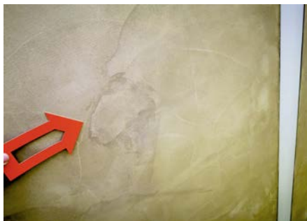
(5) Optische Auffälligkeiten aufgrund einer nicht fachgerechten Ausführung
